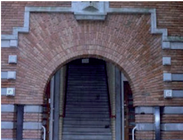
Gemetselde boog voor grotere overspanningen
