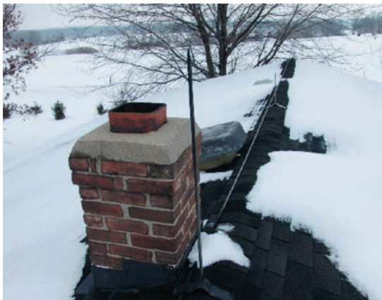
Vangdraad met opvanglers over de nok van het gebouw.
