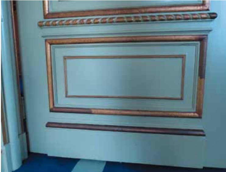
Door gebruik van verf met instabiele pigmenten, zijn de reparaties aan de vergulding donker gekleurd.
