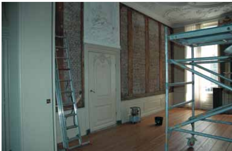
Houten constructie klaar voor hergebruik.
