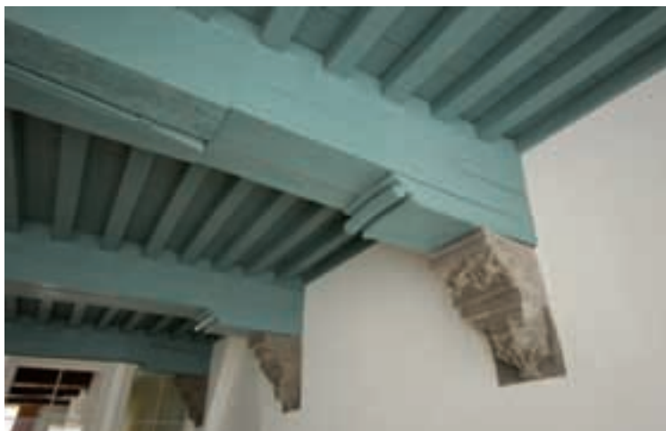
Balklagen op de eerste verdieping in Het Zeepaert.
