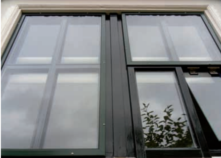
Isolatie buiten: mix van voorzetramen, klapraampje en dubbel glas.
